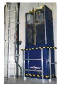
**Une échelle fixe** est installée du bas de l'éolienne jusqu'à la nacelle. Elle permet un accès au différents paliers. Elle est munie d'un équipement de protection individuelle contre les chutes de hauteur, généralement un antichute coulissant.
