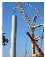
Le mat mesure entre 50 et 130 mètres avec une base de 4 à 7 mètres de diamètres pour un poids de plus d'une centaine de tonnes.
