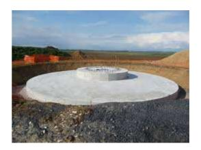
Les fondations sont d'un seul bloc de béton armé. Elle inclue une virole ou une cage d'ancrage.
