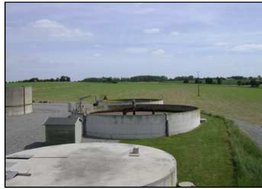
Installation de traitement
